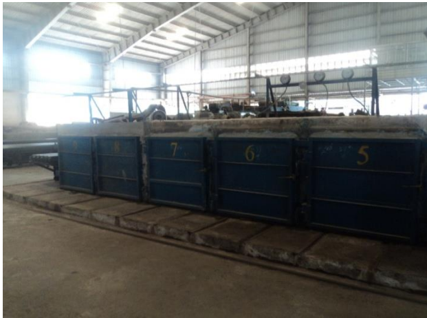
Hình 17. Hầm dưỡng hộ tấm (ủ) của Công ty Đông Anh - Hà Nội
