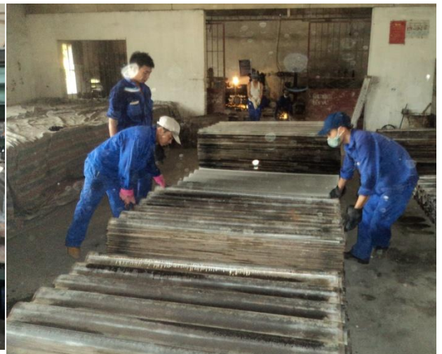
Hình 20. Dỡ tấm thủ công ở Công ty VLXD Gôi-Vụ Bản-Nam Định
